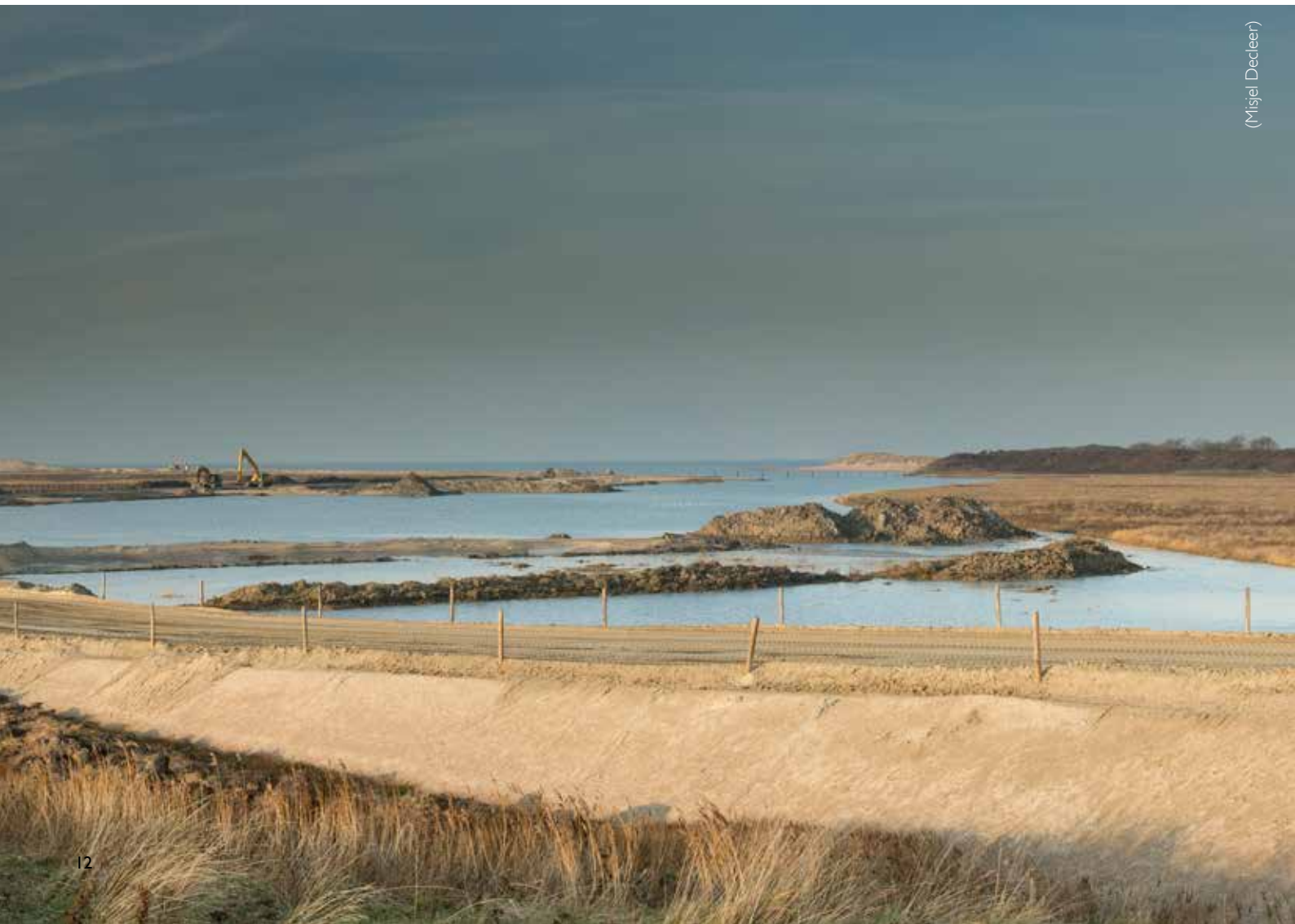
Travaux dans le chenal du Zwin
